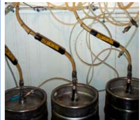
Bild 4: Bierleitungen mit Aktivatoren. Die zugehörige Kontrolleinheit ist nicht dargestellt.
