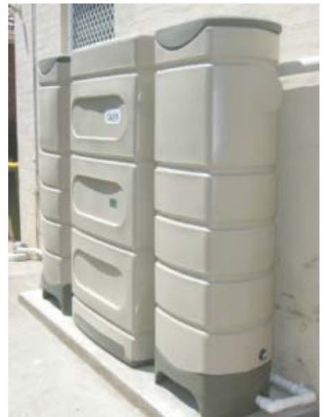
Bild 2: Anlage für Ein- und Mehrfamilienhäuser mit bis zu 1.200 Litern Grauwasser pro Tag.
